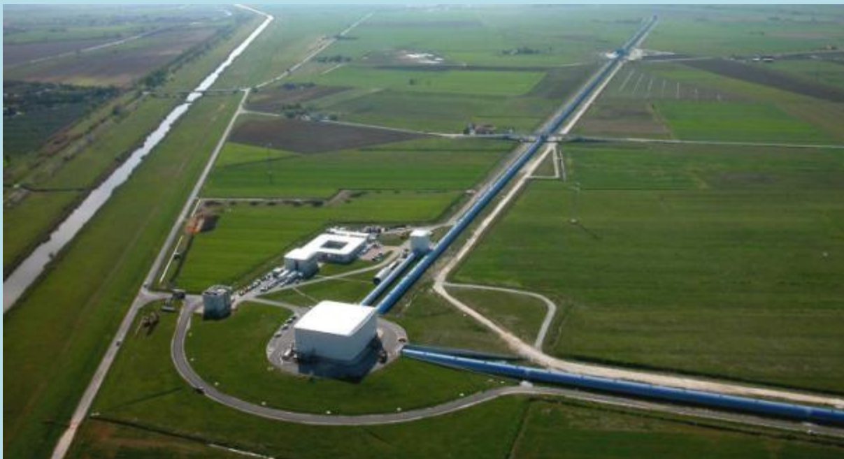
Франко-итальянский детектор Virgo, вид с воздуха на центральное здание, трёхкилометровое западное плечо и начало северного плеча (когда пространство-время сжимается, изменяется длина плеч: одно становится длиннее, а другое короче). Прочие здания — это офисы, мастерские, компьютерные залы и зал управления интерферометром. Фото: The Virgo collaboration/CCO 1.0
