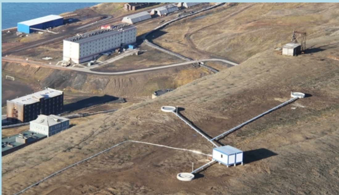
Бетонные фундаменты на горе в районе Баренцбурга имеют около четырёх метров в диаметре. Губернатор требует снести все конструкции до 15 мая (фото: губернатор Арилд Лиссанд)
